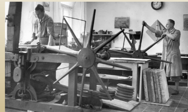
Im Drucksaal des Landesvermessungsamtes wurden die in Kalkstein geritzten und mit Farbe bestrichenen Landkarten mit Sternpressen von Hand vervielfältigt.
